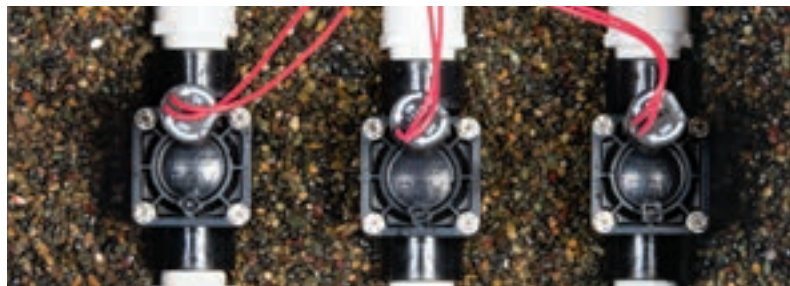
Zainstalowany PGV-100G
